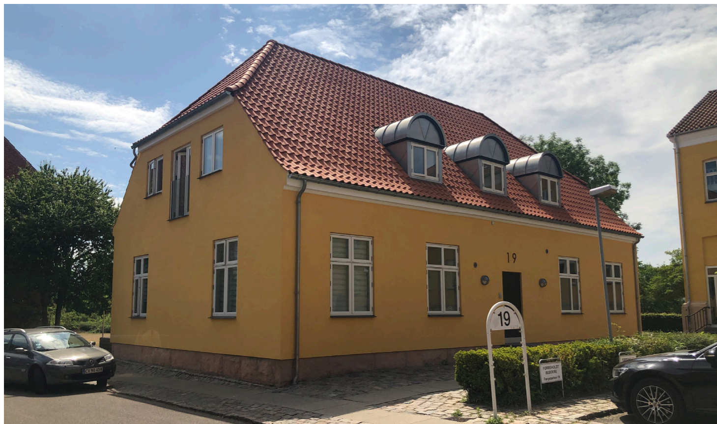
Eksisterende forhold - manglende ovenlys i tagfladerne
