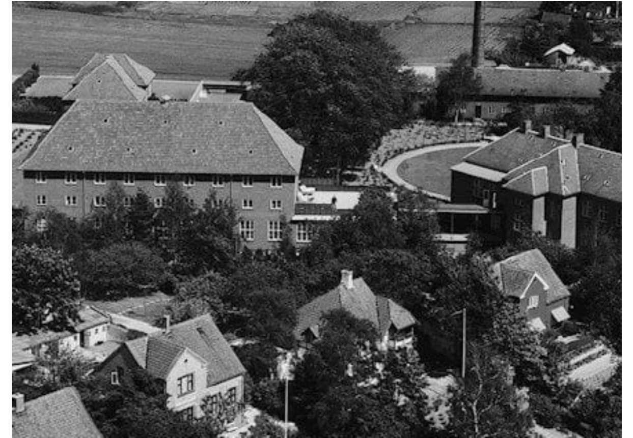
Originalfoto af bygning D samt mellembygning imellem bygning C og D
