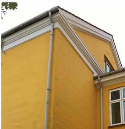
Foto - Profileret gesims og savsnitsgesims på bygning fra 1871
