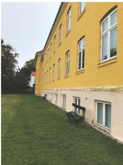
Facade mod Færgevej set fra syd
