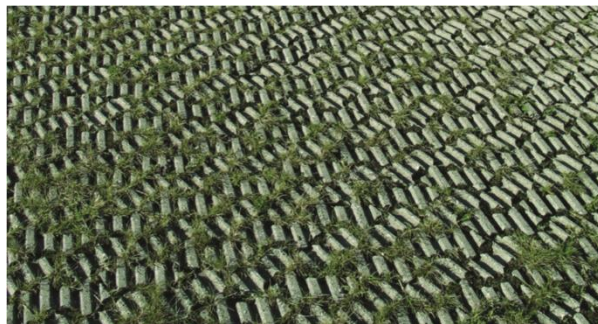
Figur 1 Eksempel på permeabel belægning.
