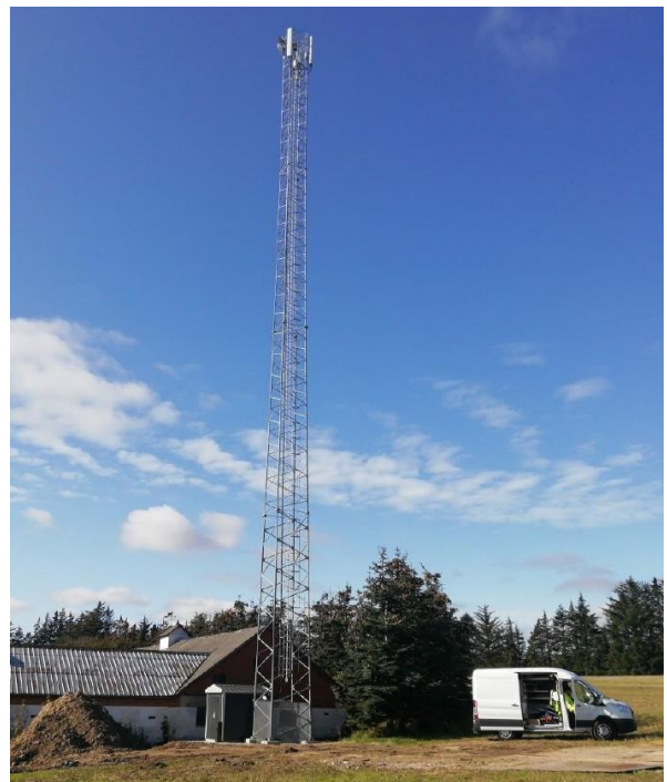
Figur 4 Eksempel på gittermast med en højde på 48 meter.
