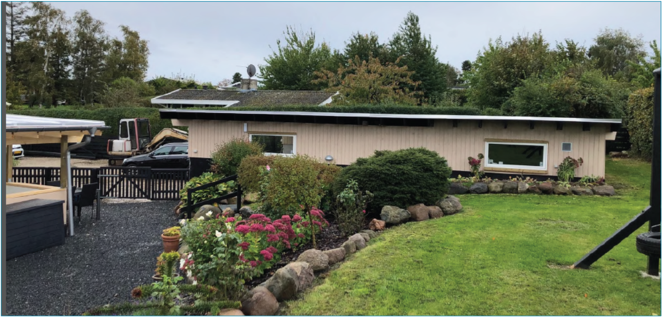
Fotos af carport med udhus på i alt 110 m 2
