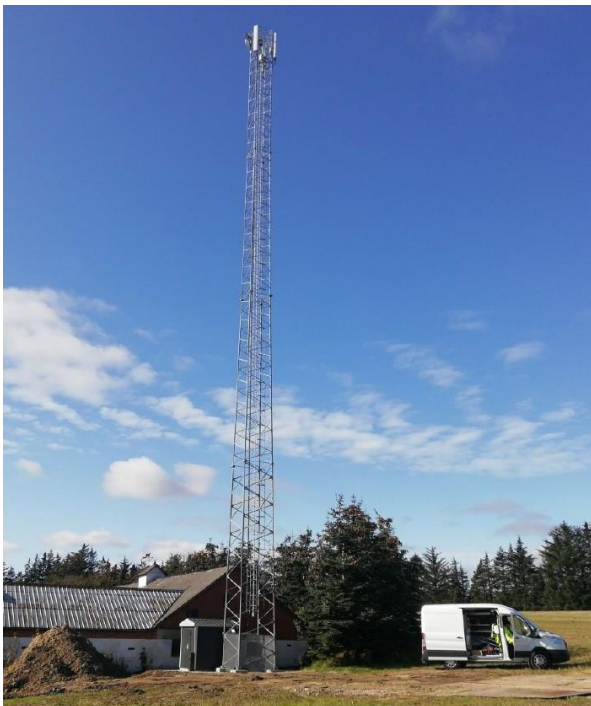
Figur 5 Eksempel på gittermast med en højde på 48 meter.
