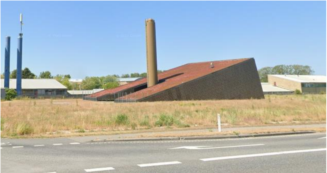
Den nye Risø bygning
