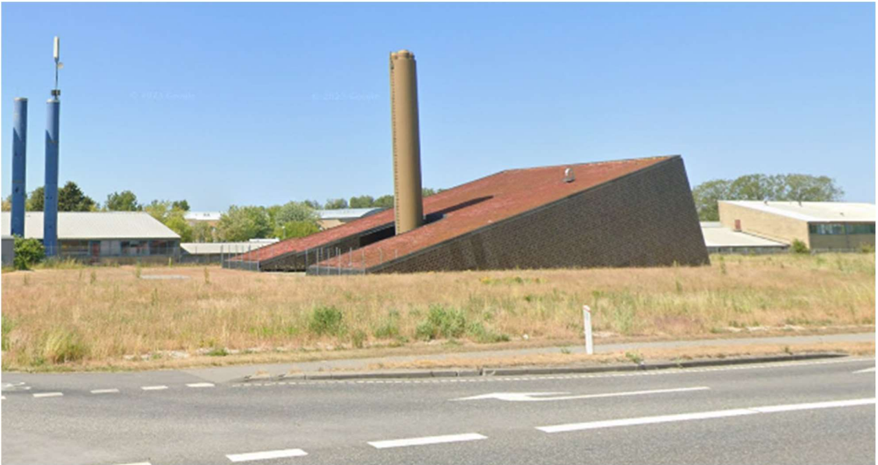
Den nye Risø bygning
