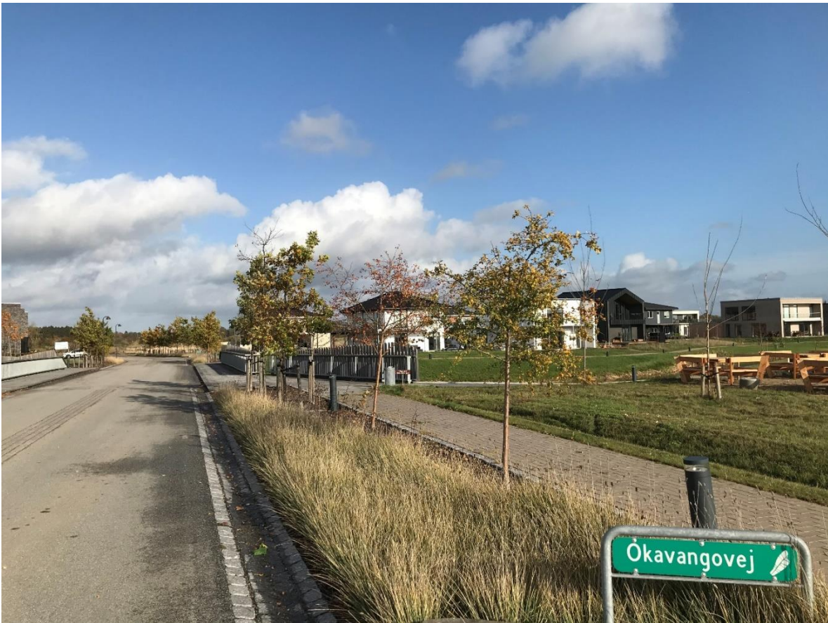
Under planlægningen af den nye by Vinge er der udlagt arealer til plantebede med træer langs Deltavej. Arealudlægget giver Deltavej et grønnere og mere sammenhængende visuelt udtryk.
