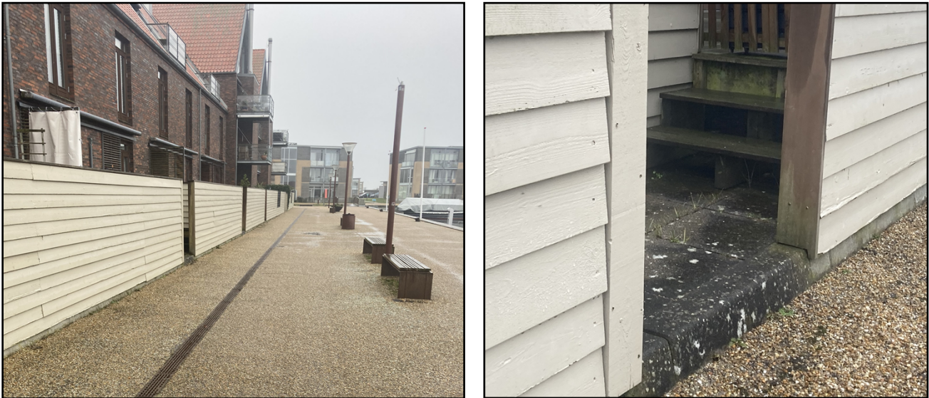
Figur 3.1: Rækværk og indgange ind til Amsterdamhusenes terrasser vist fra gangarealet langs kajen. Foto: NIRAS 12-03-2023.
