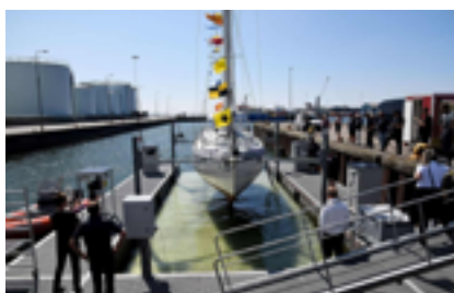
Flydende vaskeplads med rensningsanlæg
