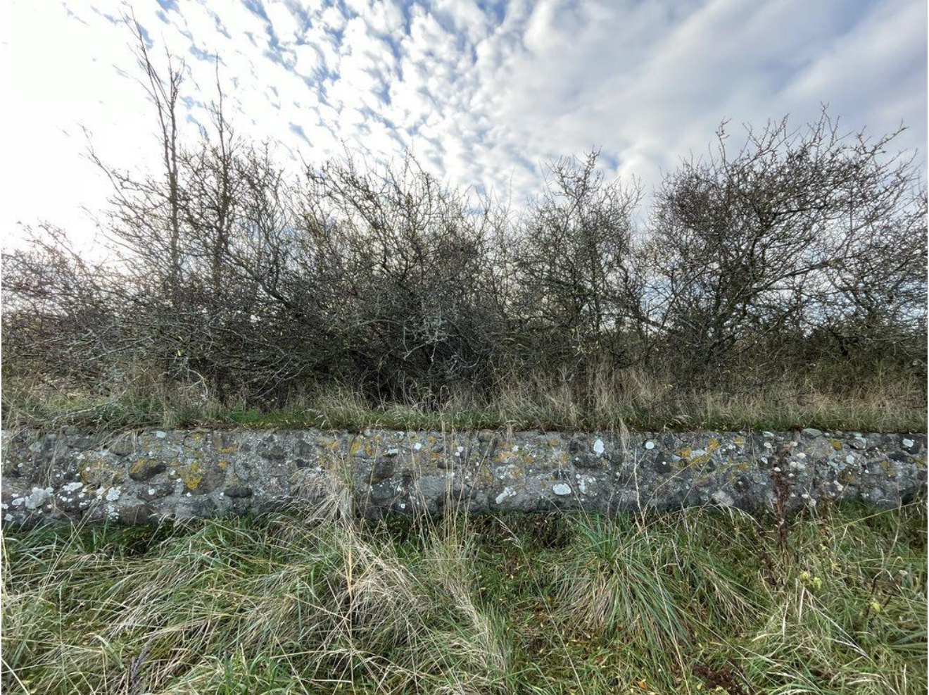
Figur 2: Dige ved det østlige Kulhuse. Foto: NIRAS, 2. november 2022.
