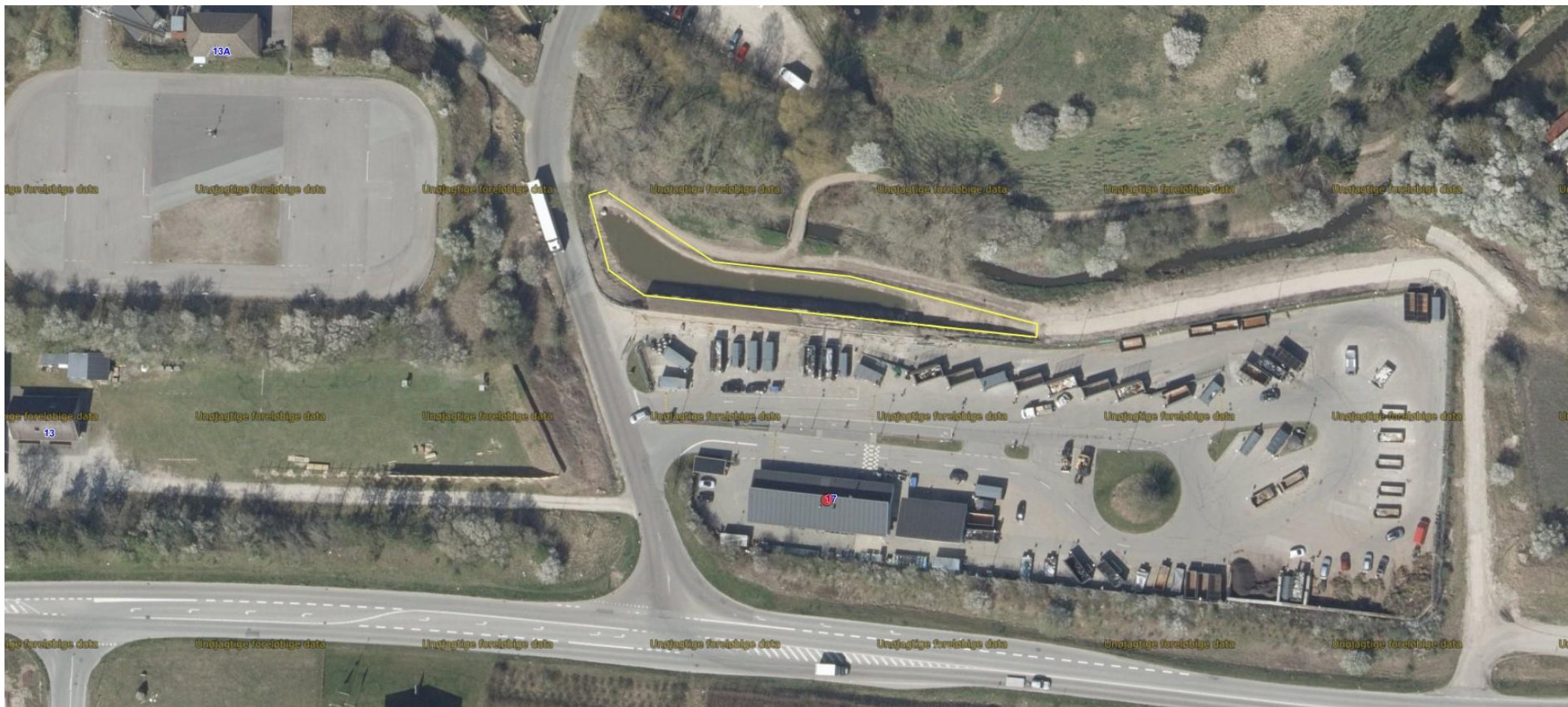
Den gule markering omkredser det udvidede regnvandsbassin ved Strandvangen/Frederikssund genbrugsplads.
