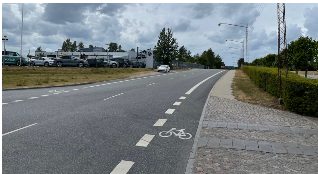
På Holmensvej er der ensidigt fortov og cykelbaner på strækningen vest for Smedetoften (vest).
