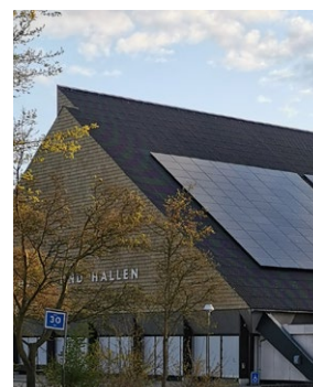
Elektrificering af opvarmning og transport kræver vedvarende energi.
