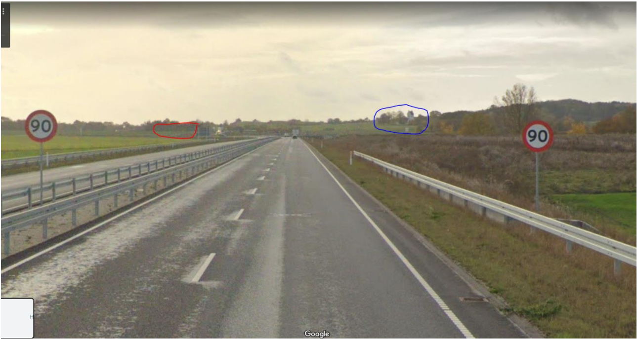
Figur 11 Fra nord ad Fjordlandsvej ca. 900 m fra placering
