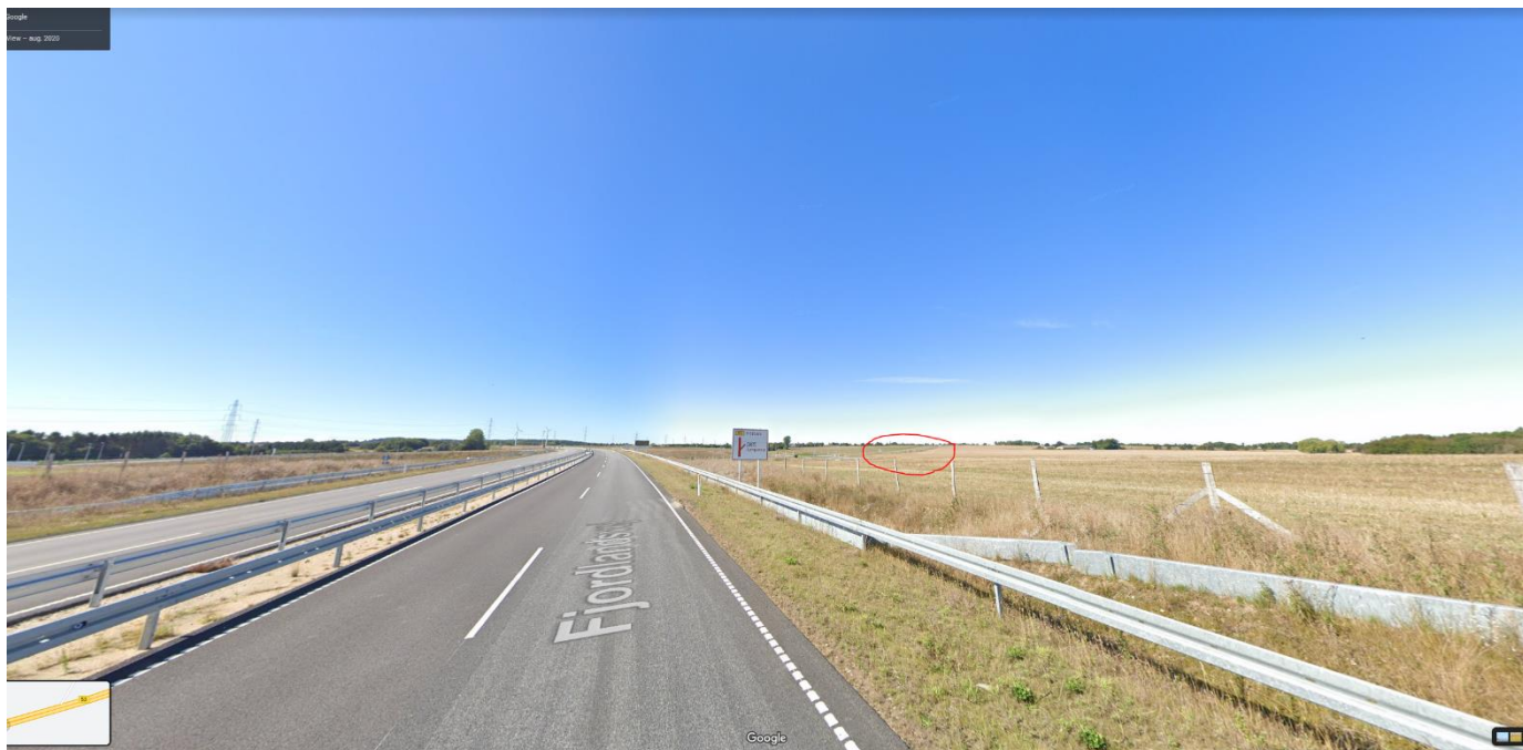
Figur 3 Fra nord ad Fjordlandsvej ca. 400 m fra placering
